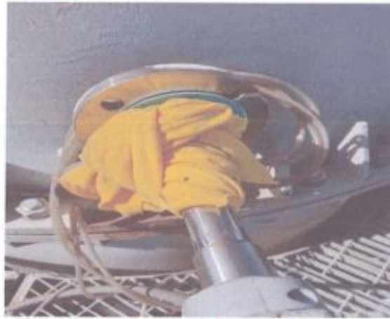
RTO 设备尾气排气筒出口 (Q1 出口)
